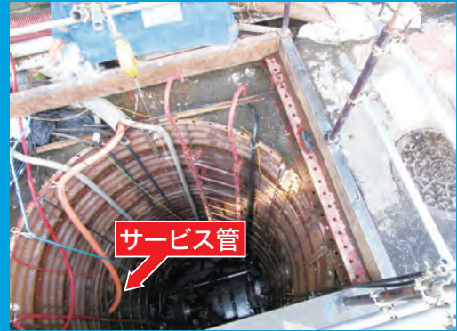
サービス管を立坑から直吸い
