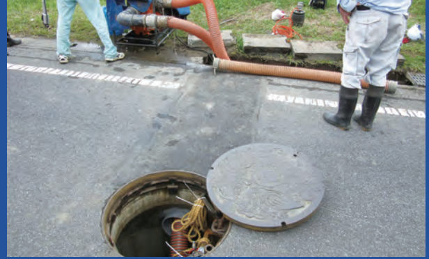
仮配管を地下とU字溝に埋設
