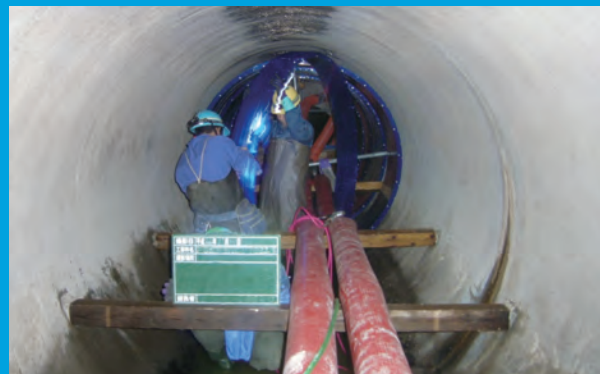
【大口径更生工事】 \phi 2000\text{mm} , 流量 7.5\text{m}^3/\text{分} (左)吸排水を1箇所の入孔で (右)管内配管による水替
