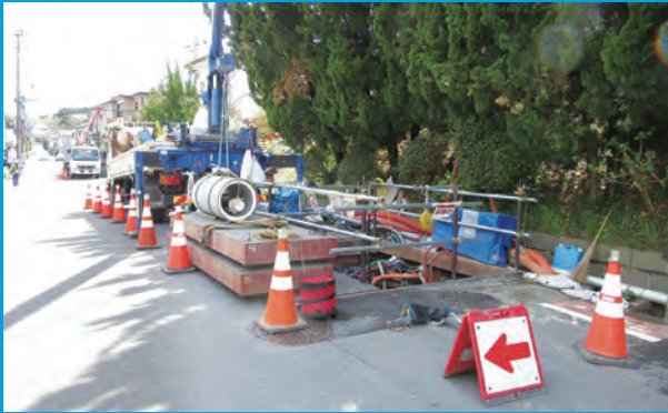
【改築推進工事】 本管を1スパン水替
