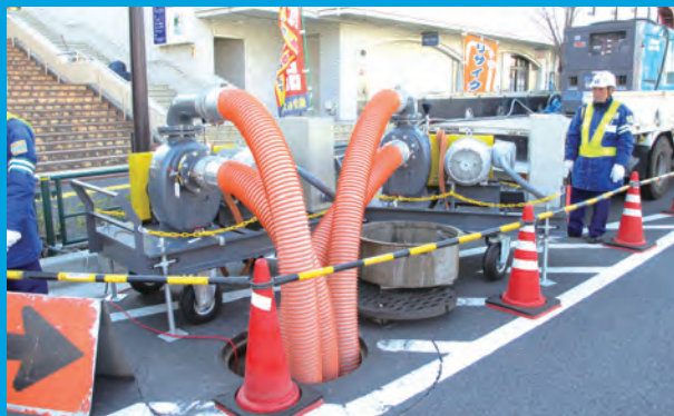
【大口径更生工事】 \phi 2000\text{mm} , 流量 7.5\text{m}^3/\text{分} (左)吸排水を1箇所の入孔で (右)管内配管による水替
