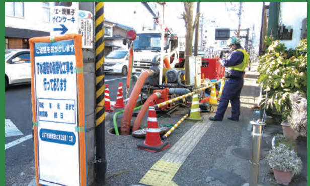
【管更生工事+人孔管口耐震化工事】
