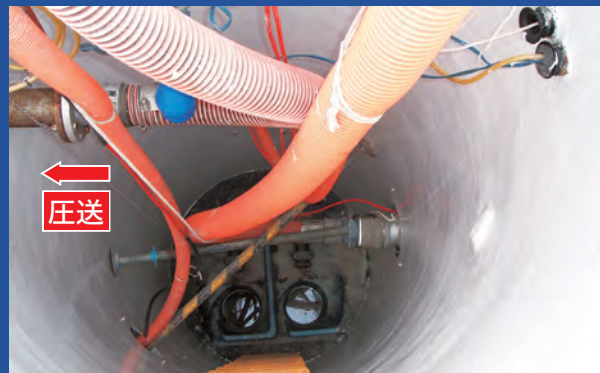
水替中：全3箇所を直吸い+圧送管へ接続
