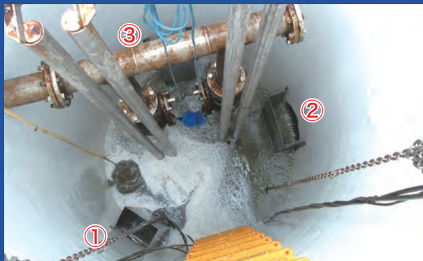
【マンホールポンプ改修工事】 施工前：3方向からの流入
