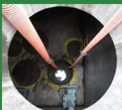
【伏越し・下流側】
