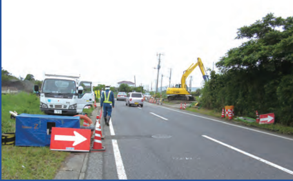
【布設替工事】 常時水替時の交通規制なし
